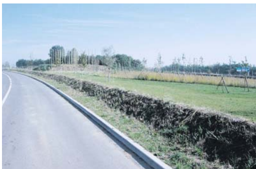
Talus d'accompagnement de voirie - Zone d'Artoipole II
